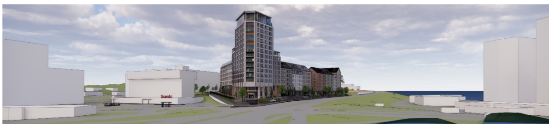
Bild 16. Vy från trafikplats Roslags-Näsby, med Techfarms höga hus i förgrunden.
